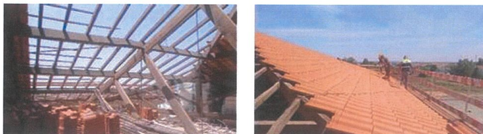
Imagem 4 – Centro de Acolhimento de Vendas Novas: Trabalhos na cobertura do edifício
