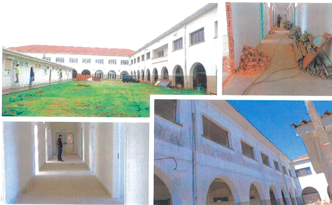
Figura 6 – CA Vendas Novas: Imagens da Obra
